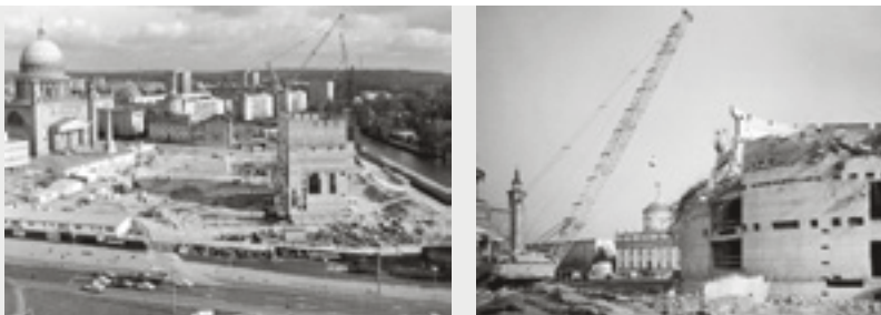
(1) Alter Markt Potsdam mit Theater-Baustelle, März 1990 (2) Abriss des Theaterrohbaus, 15. Oktober 1991
