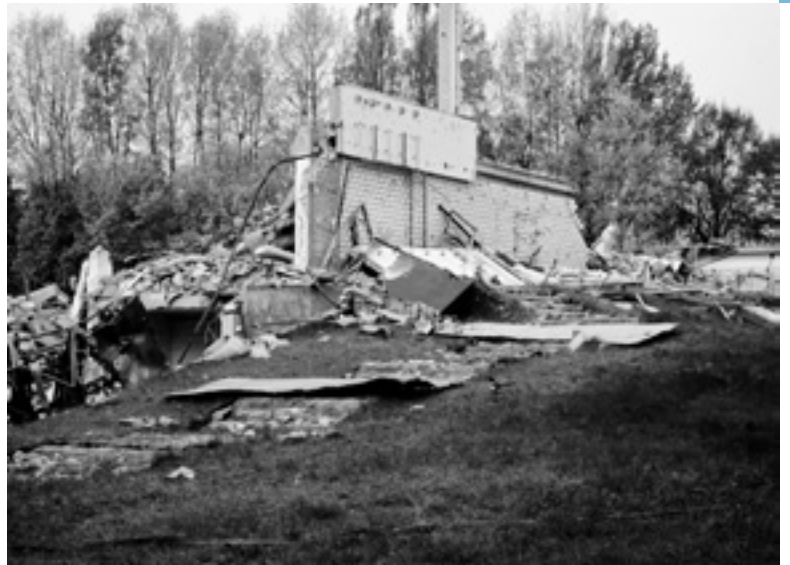
2011 wurde das seit langem leerstehende ehemalige Kulturhaus Eberswalde abgerissen.
