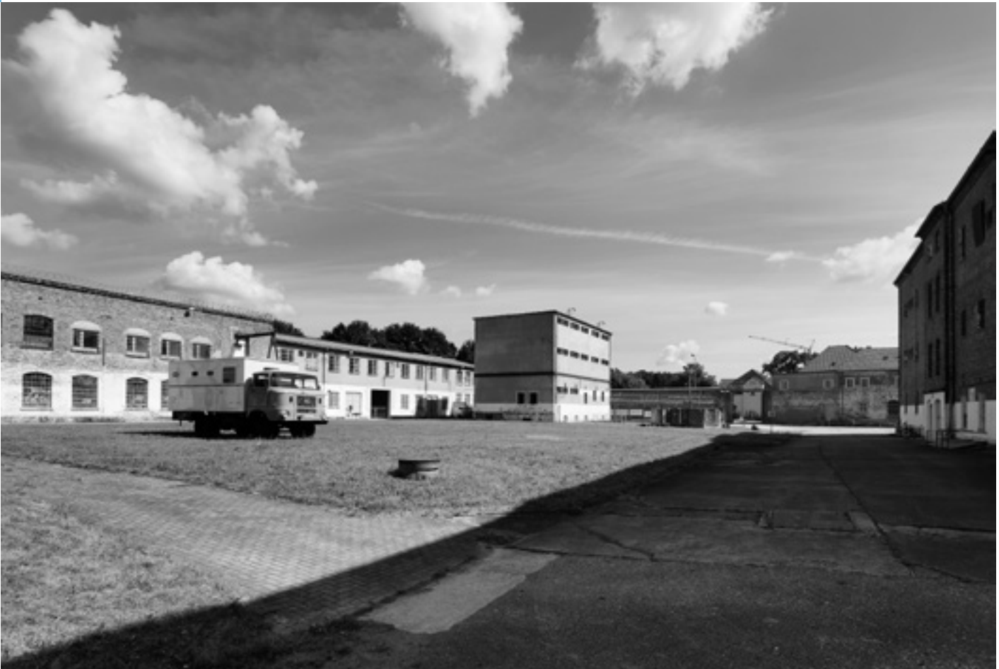
Blick über den größten Innenhof des Areals Gedenkstätte Zuchthaus Cottbus, links die Gebäude der Pentacon-Werkshallen, rechts das Hafthaus 1
