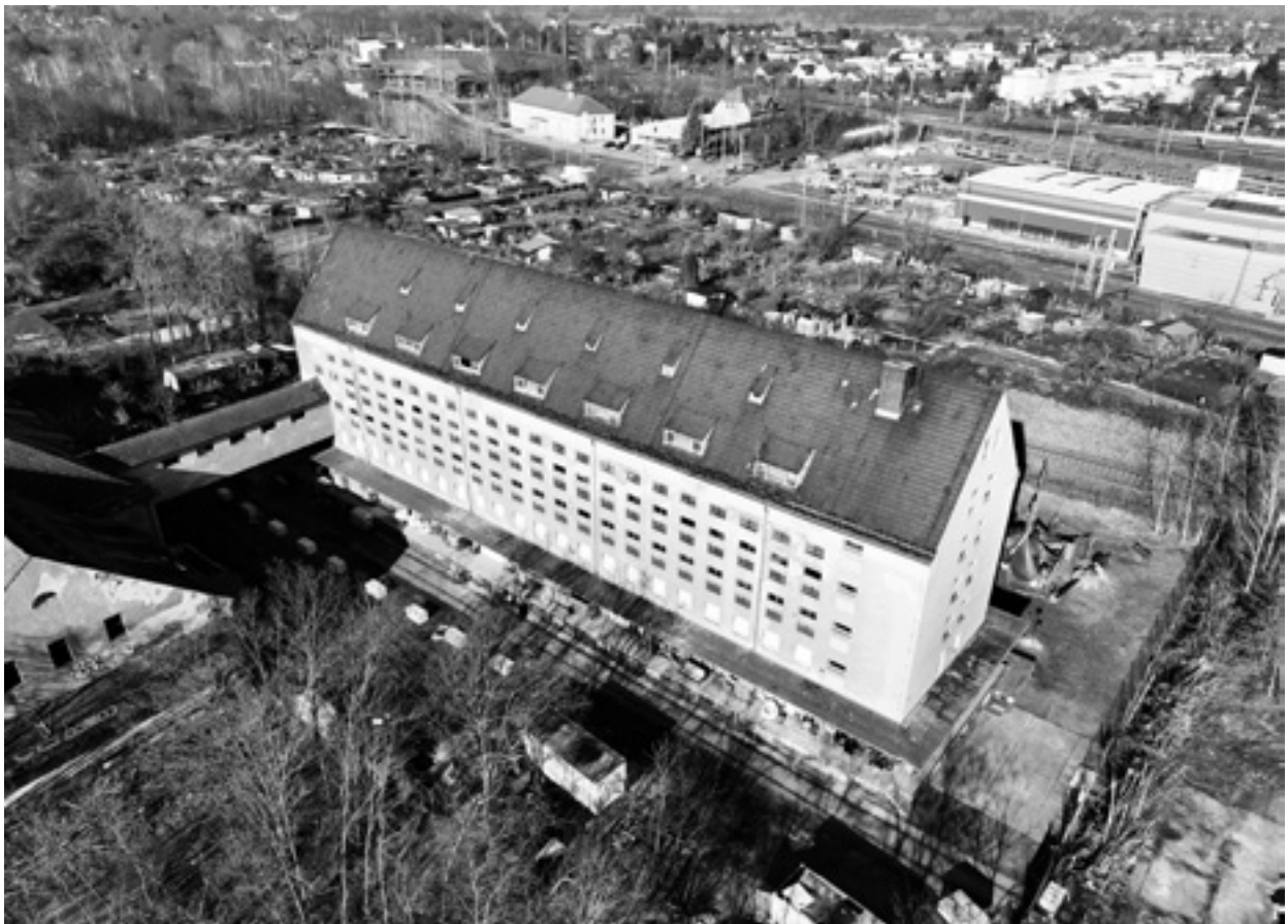
Luftaufnahme eines der beiden alten Kornspeicher mit Übergang zur ehemaligen Großbäckerei, im Hintergrund Teile des Cottbuser Bahnwerkes.
