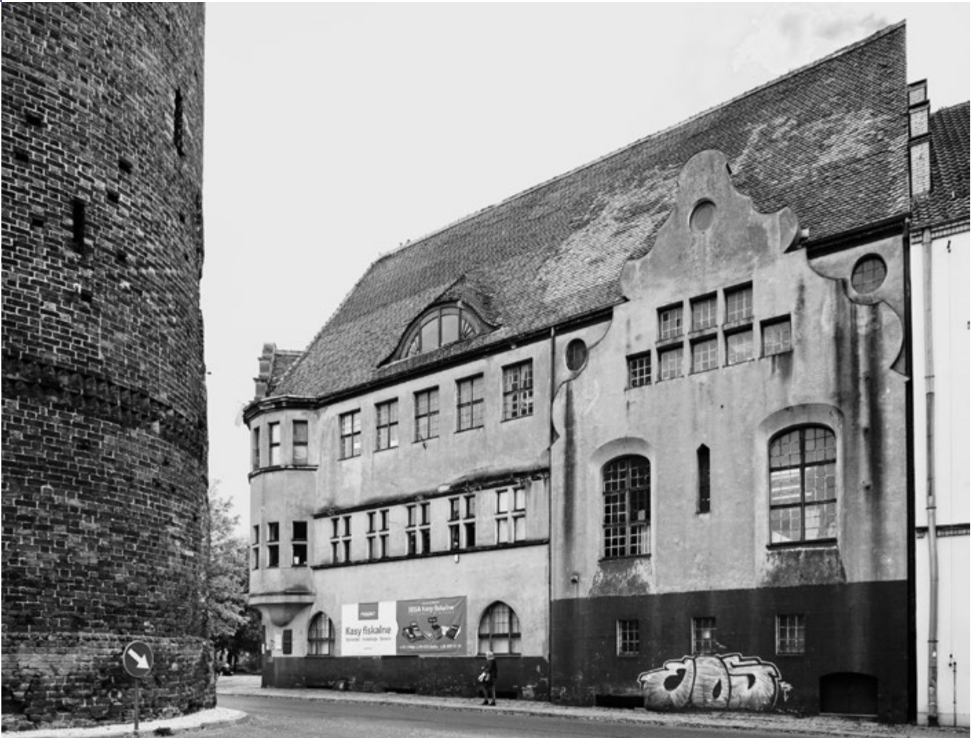
Das 1913 eingeweihte Gebäude des ehemaligen Gubener Stadtmuseums im Jahr 2022. Budynek dawnego muzeum miejskiego wzniesiony w 1913 r., 2022.
