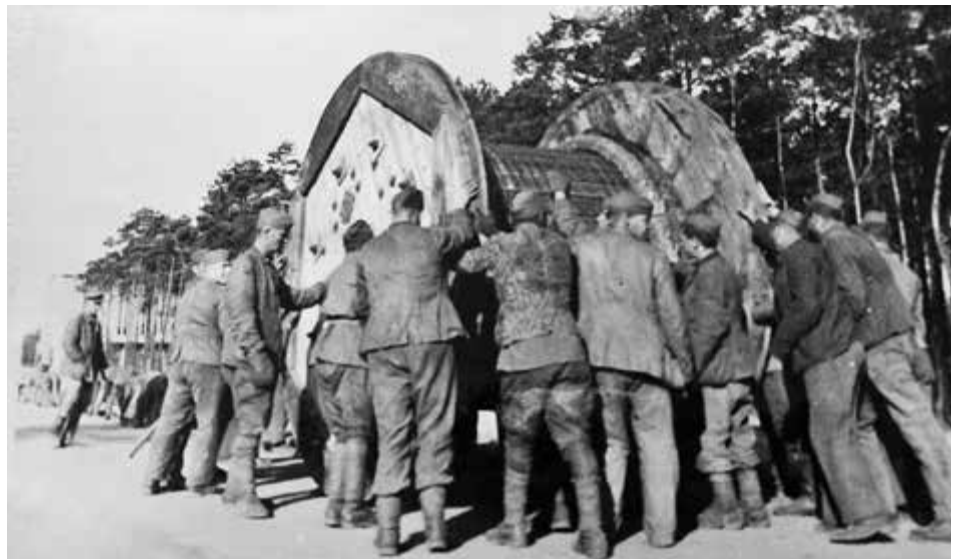
Abbau von Starkstromkabeln durch sowjetische Demontagebrigaden 1946
