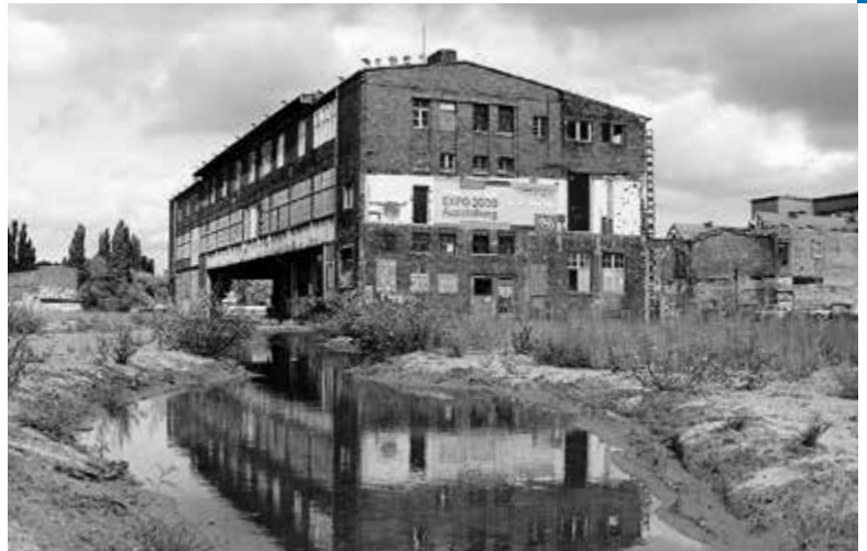
Werkstattgebäude des ehemaligen Glaswerks Stralau in Berlin-Friedrichshain. 2000 war es ein Solitär westlich der Glasbläserallee.
