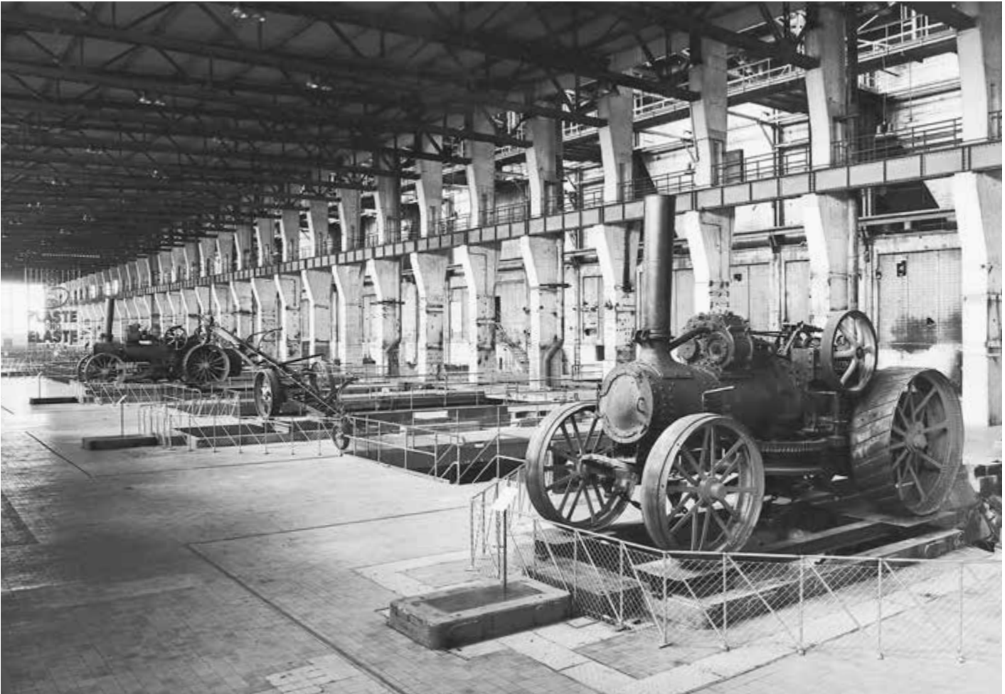
Maschinenhaus des Kraftwerks Vockerode bei der Eröffnungsausstellung „mittendrin – Sachsen-Anhalt in der Geschichte“. Zwei Lokomobile und ein Magdeburger Kippflug auf den Fundamentrahmen der Generatoren.
