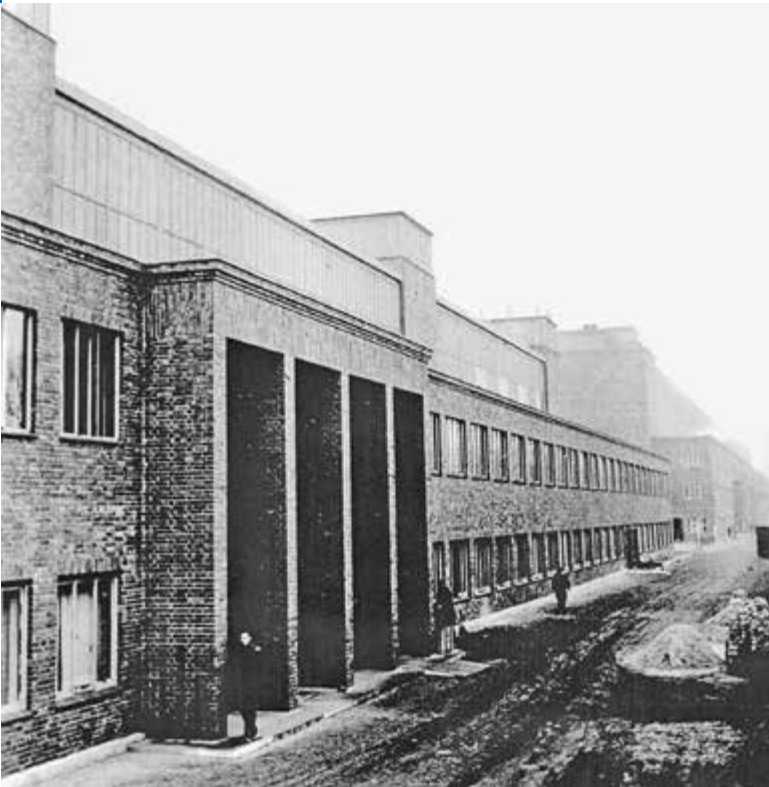
Das Werk Hennigsdorf der Mitteldeutschen Stahlwerke AG, 1935.
