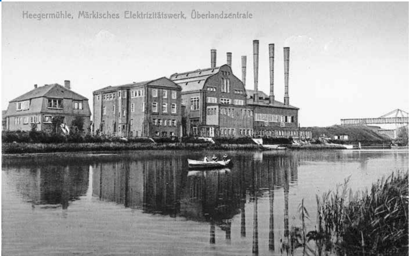
Das Kraftwerk Heegermühle bei Eberswalde, Ansichtskarte von 1917.
