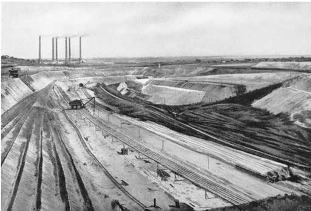
Tagebau der Braunkohlengrube Finkenheerd, im Hintergrund das Kraftwerk. (aus: „Das Märkische Elektrizitätswerk. Ein Überblick über die ersten 25 Jahre seiner Entwicklung, Berlin 1934.)
