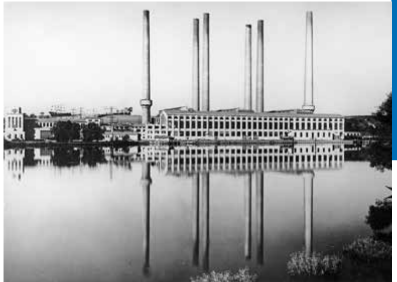
Das Großkraftwerk Finkenheerd, Foto um 1940.
