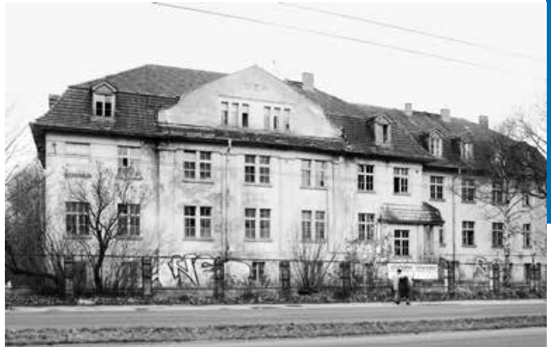
Das Verwaltungsgebäude des MEW in Eberswalde im Jahre 2008. Das Gebäude wurde 2015 abgebrochen.
