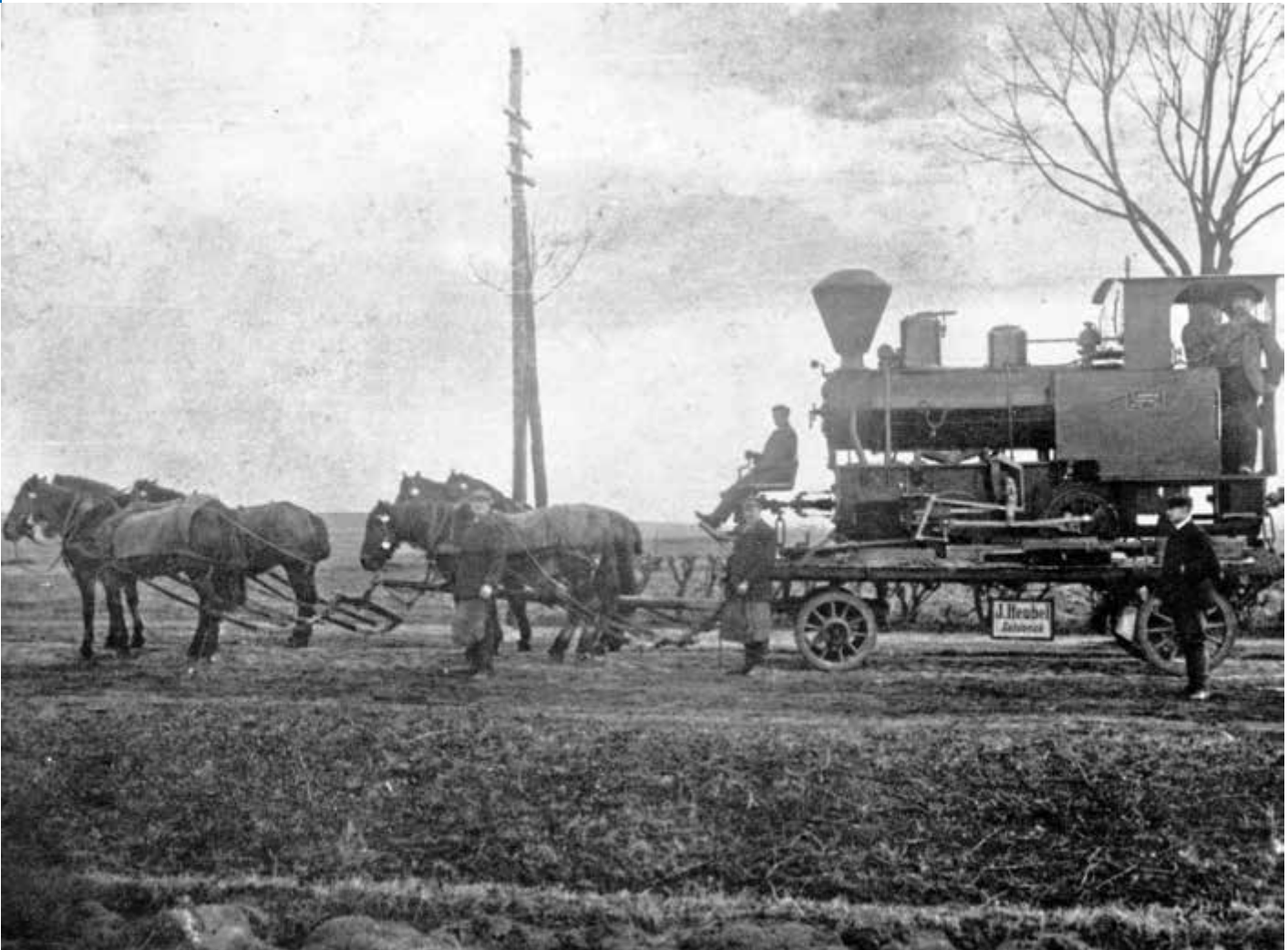
Transport einer Feldbahn-Dampflokomotive vom Bahnhof Zehdenick zur Ziegelei Mildenberg. Da die Ziegeleien keinen Anschluss an die Normalspurbahn hatten, mussten Loks und Anhänger der Feldbahn auf dem Pferdefuhrwerk zu ihrem Einsatzort gebracht werden.
