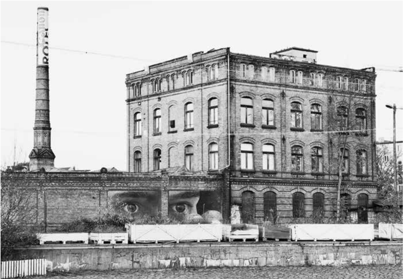
Ehemalige Segeltuchfabrik Max Lehmann am Hauptbahnhof Cottbus, Gebiet der Westlichen Stadterweiterung. Künstler einer benachbarten Galerie verschönern zurzeit die Mauern des Industriegeländes mit Streetart.
