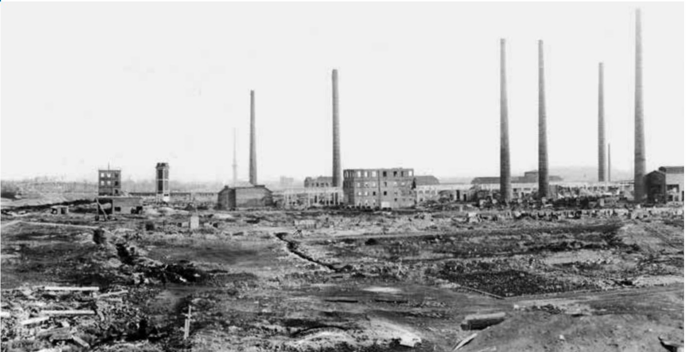
Das demontierte Stahl- und Walzwerk Brandenburg an der Havel im Jahr 1947.
