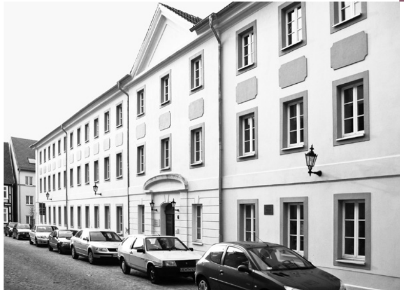
Die Alte Kaserne in der Diesterwegstraße im Jahr 2008. Das Gebäude wurde 1996/97 von außen saniert und als Büro- und Geschäftshaus genutzt.
