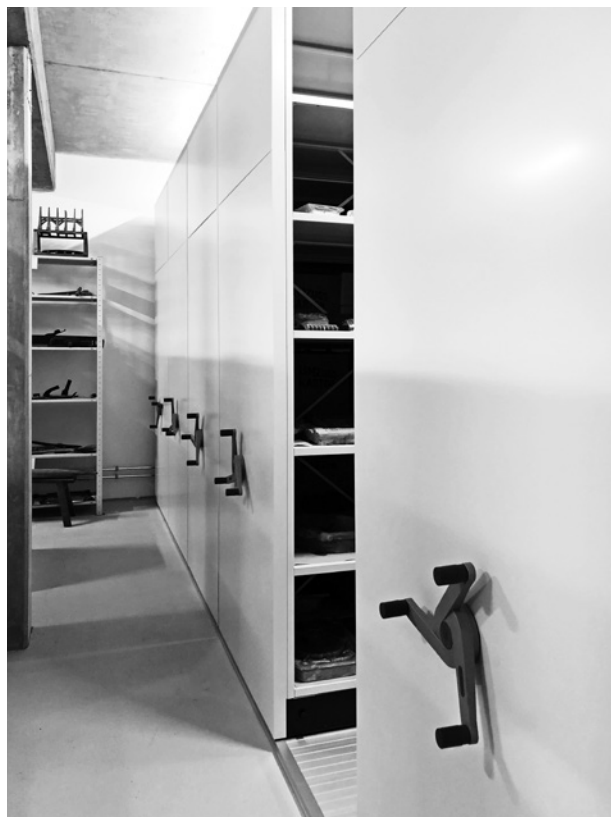
Hebelschubanlage im neuen Museumsdepot
