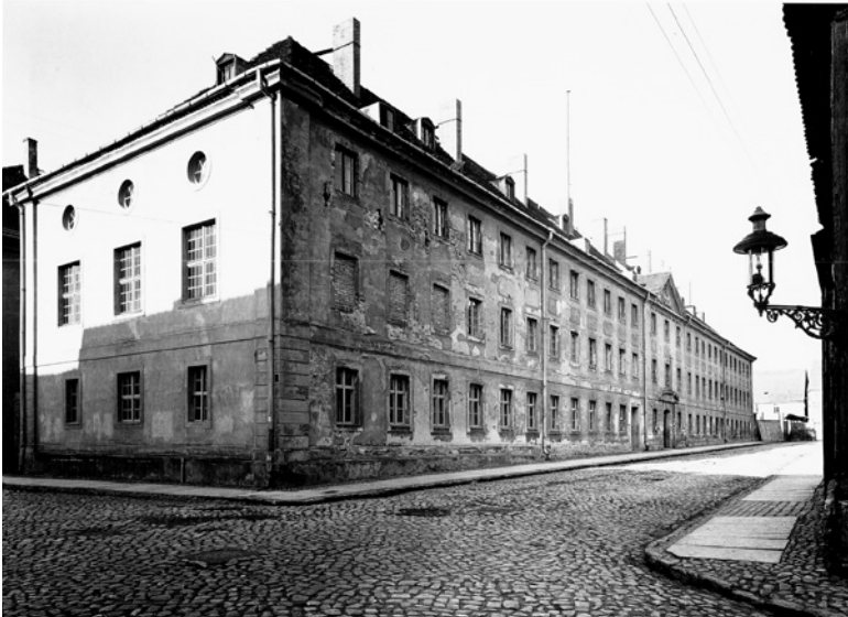
Bauzustand der Alten Kaserne im Jahr 1931. Der Gebäudekomplex wurde von 1767 bis 1770 errichtet.
