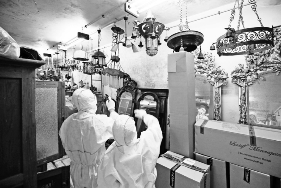
Schimmelbefall an den Wänden
