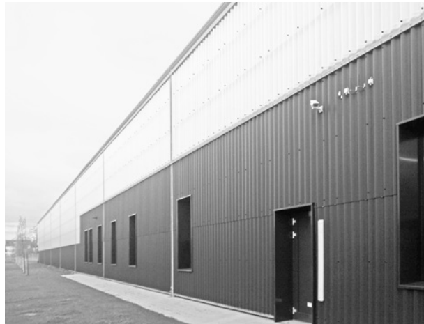
Zentrales Kunstdepot der Städtischen Museen Freiburg im Breisgau, errichtet 2011–2012
