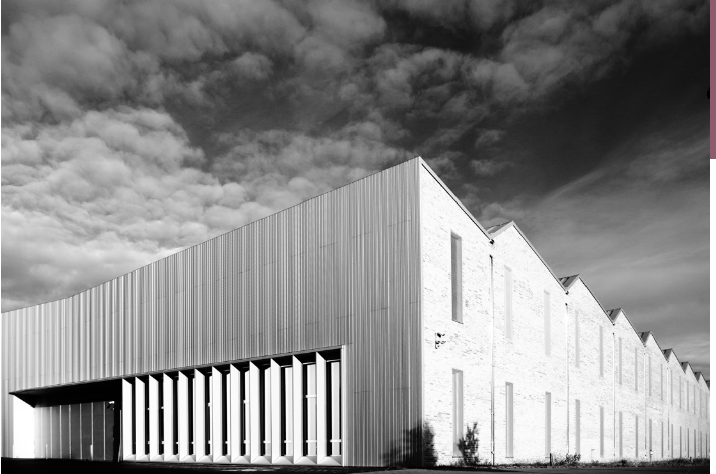
Das neue Zentraldepot, Ansicht von der Straßenseite.
