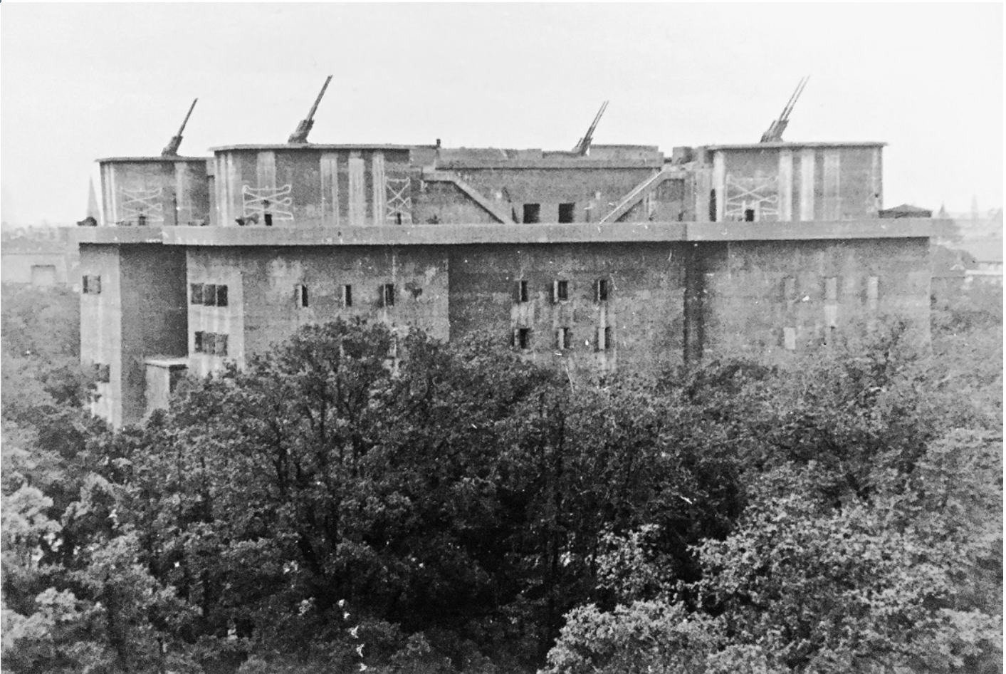
Einer der Hauptbergungsorte der Nationalgalerie: Der Flakturm (Geschützturm) am Zoo, Aufnahme um 1942
