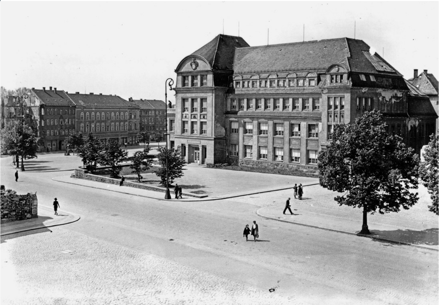
Das Stadtmuseum Bautzen mit kriegszerstörtem Dach sowie Wohn- und Geschäftshäuser am Kornmarkt, Bautzen, Mai 1946.
