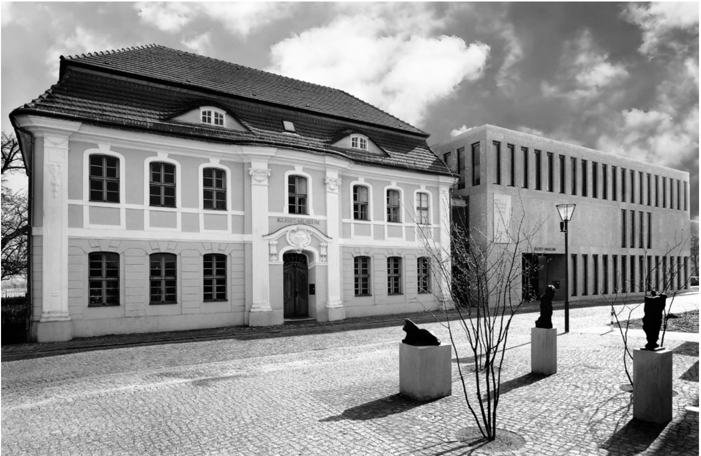
Ein besonderes Ensemble in Frankfurt (Oder): links der barocke Altbau des Kleist-Museums, rechts der Anbau von 2011.
