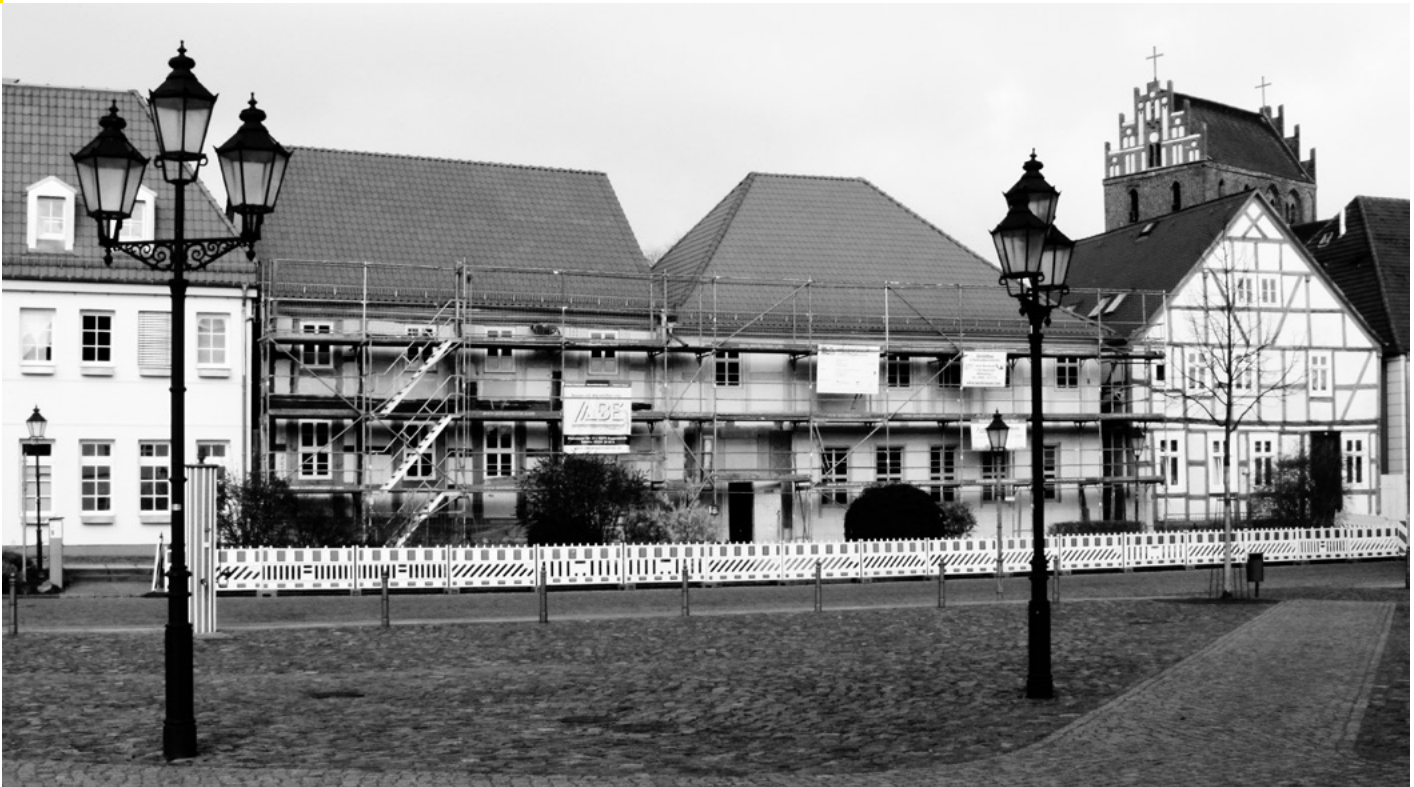
Renovierung der Häuser Hoher Steinweg 17 und 18 in Angermünde
