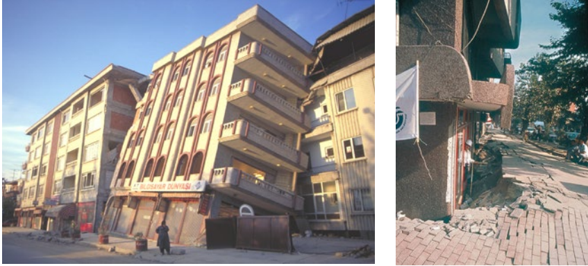
Abb. 6a und 6b: Bodenverflüssigung, Izmit 1999. Fotos: P. Lestuzzi, SGEB-Erkundungsmission
