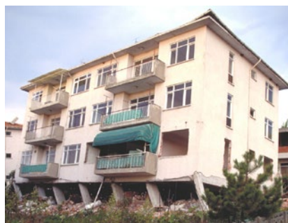
Abb. 3a und 3b: Weiches Geschoss oder „soft story“, Izmit 1999. Fotos: P. Lestuzzi, SGEB-Erkundungsmission
