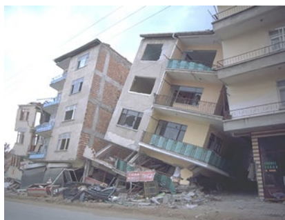
Abb. 3a und 3b: Weiches Geschoss oder „soft story“, Izmit 1999. Fotos: P. Lestuzzi, SGEB-Erkundungsmission
