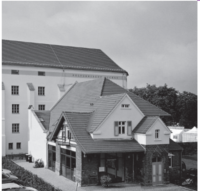
Das Kutscherhaus dient nun als stadtzugewandtes, einladendes Foyer der Kulturkirche.
